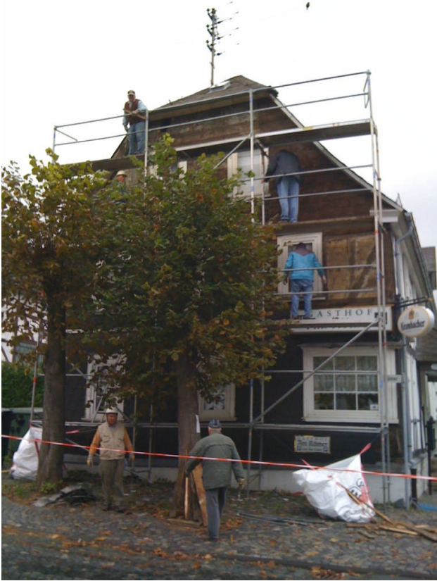
Der alte Schiefer wird abgenommen, neue Fenster eingebaut und die auch früher immer verschieferte Firstseite des Hauses Dilthey wieder neu aber jetzt traditionell verschiefert.
