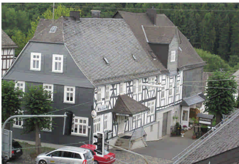
So sieht das Haus Dilthey heute aus einer eher ungewohnten Perspektive aus: Im vergangenen Jahr fotografiert vom Gerüst am Konfirmandenhaus aus. Die abschließende Sanierung der Rückfront des Gebäudes steht jetzt noch aus.
