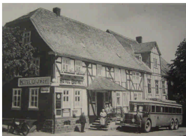
Ein Foto aus den 30iger Jahren: Omnibus-Abfahrt vor dem Haus Dilthey. Die damalige Fassade ist heute wieder hergestellt.
